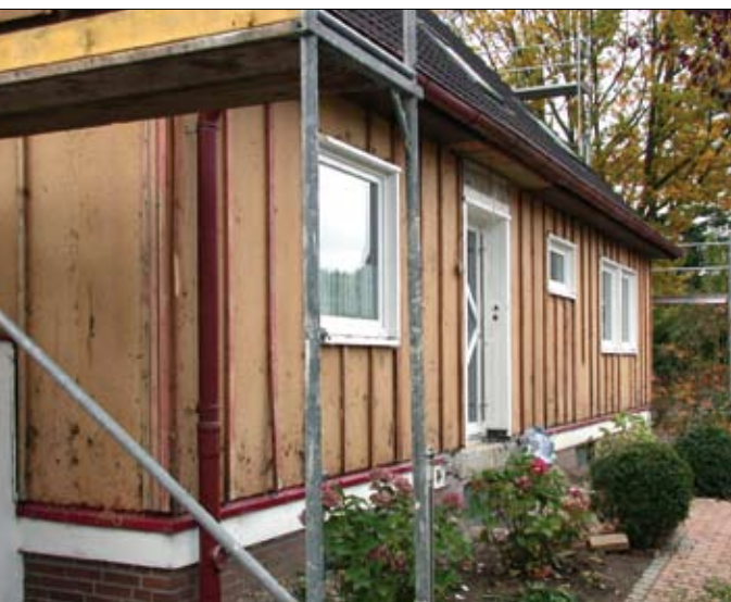
Die alte Außenhülle ist entfernt, sichtbar ist unten noch die rote Blechabdeckung, die ebenfalls abmontiert wird.
