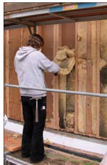
Anschließend wurde die alte Mineralwolle herausgenommen und zur Entsorgung in große Plastiksäcke verpackt.
