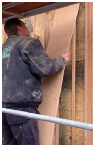
Unter der Außenhülle befanden sich mit den Tafelhölzern verbundene Spanplatten, die die Zimmerer heraus sägten.
